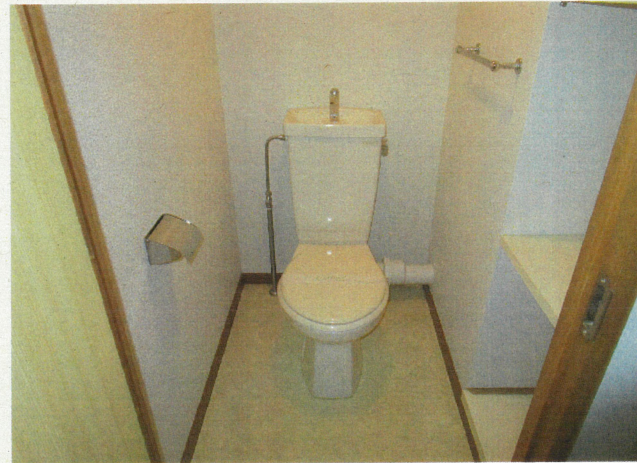
便所 (コンセント無し)
