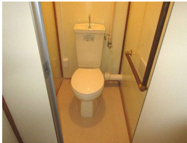
便所 (コンセントあり)
