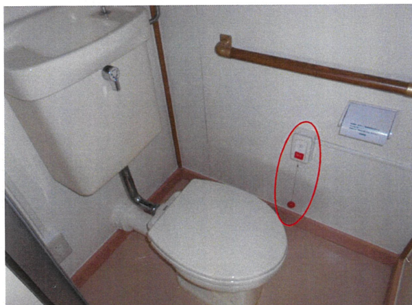
便所(コンセント有り、赤丸は非常呼出しです)
