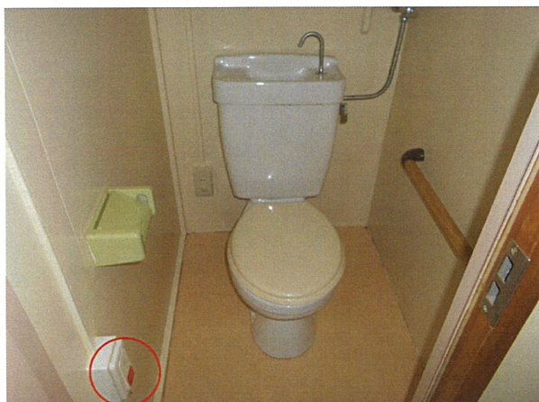
便所(コンセント有り、赤丸は非常呼出し)
