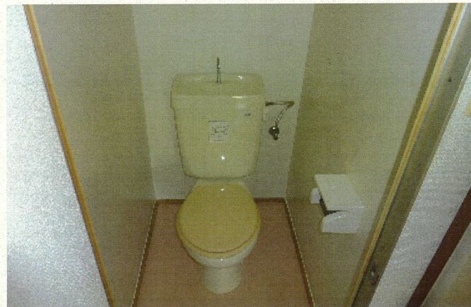
便所(コンセント無し)
